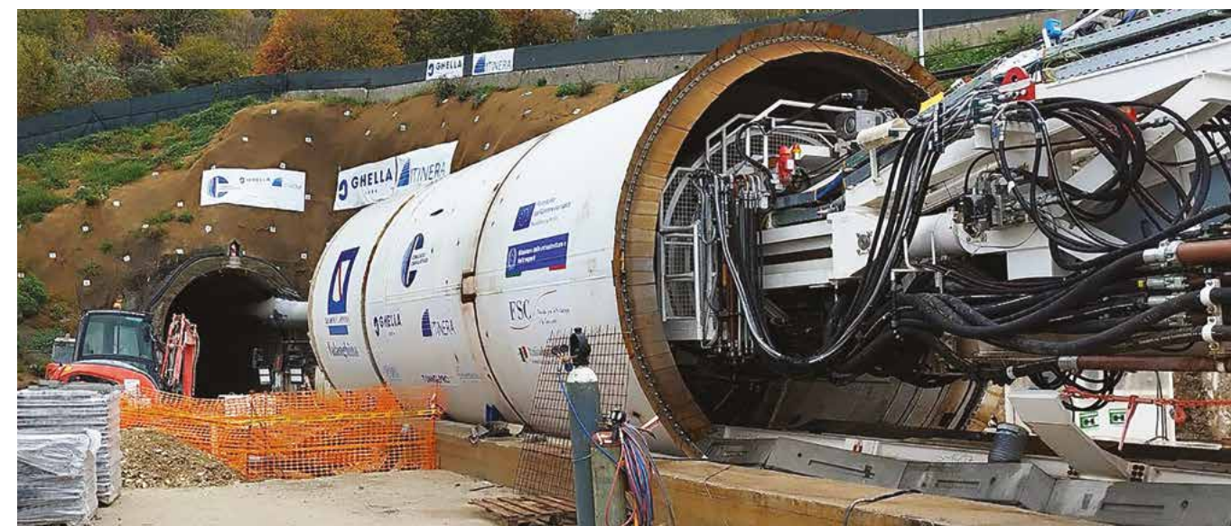
FIG. 3. LA TBM IN CANTIERE
