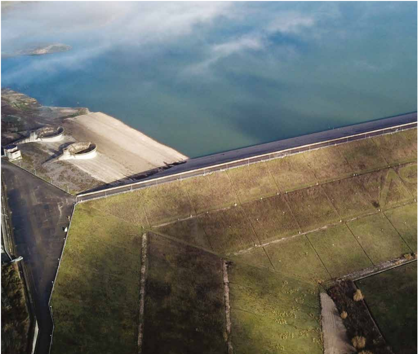
FIG. 6. VEDUTA AEREA DELLA DIGA DI CAMPOLATTARO
