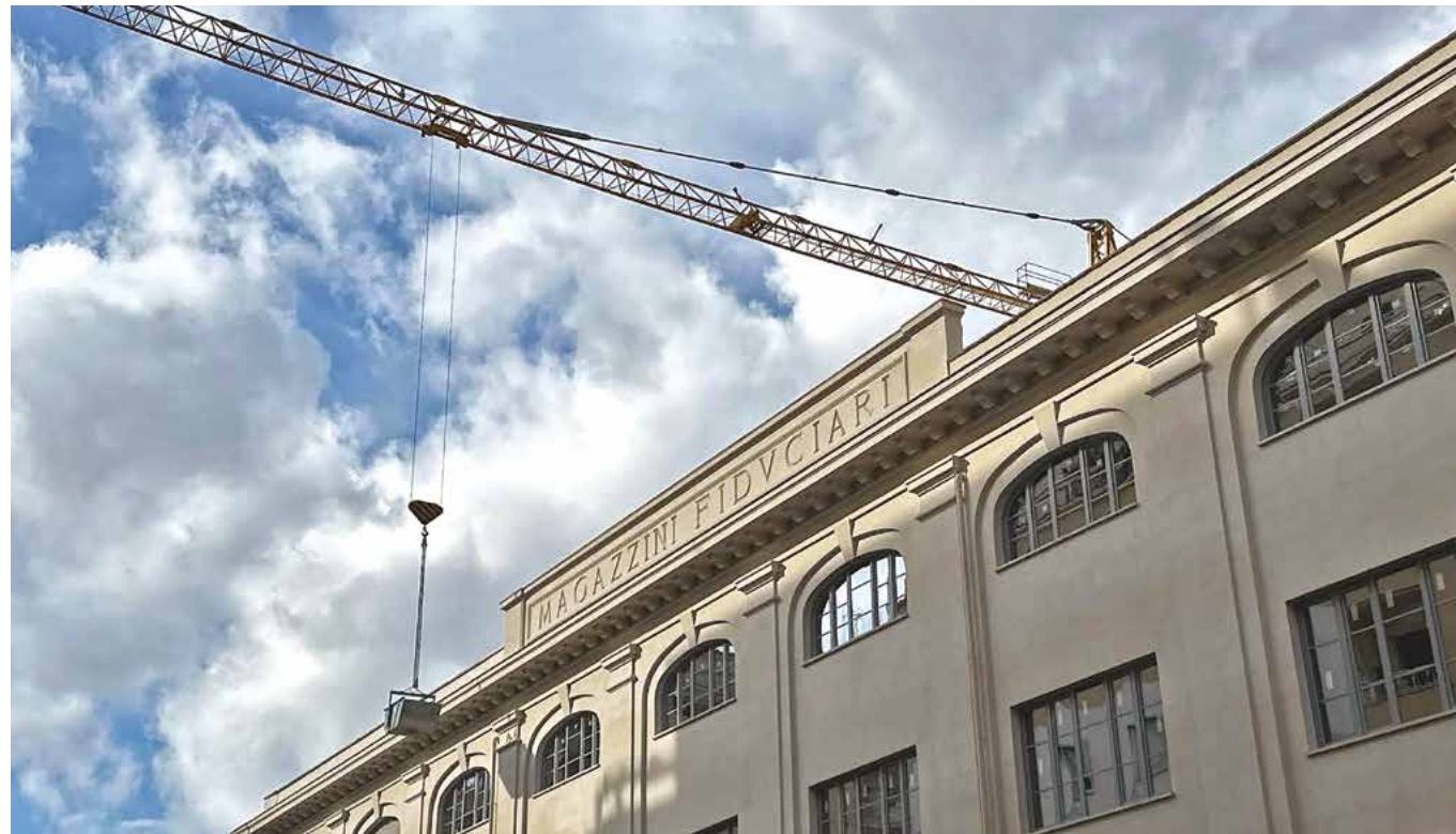
FIG. 2. IL PORTO FLUVIALE REC HOUSE OFFRE 54 NUOVI ALLOGGI ERP A ROMA
