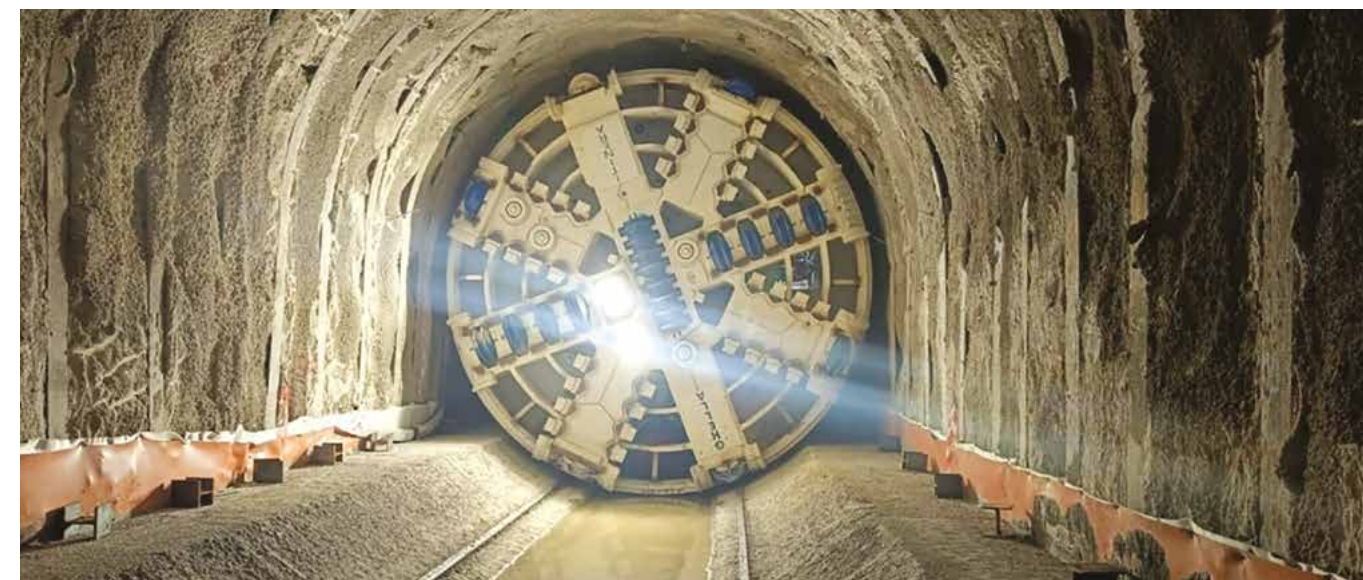
FIG. 4. IL TRATTO DI GALLERIA SCAVATO E L'IMBOCCO CON LA TBM
